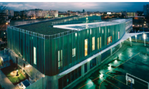
Groupe scolaire Lamoricière - Archi5 © photo Thomas Jorion
